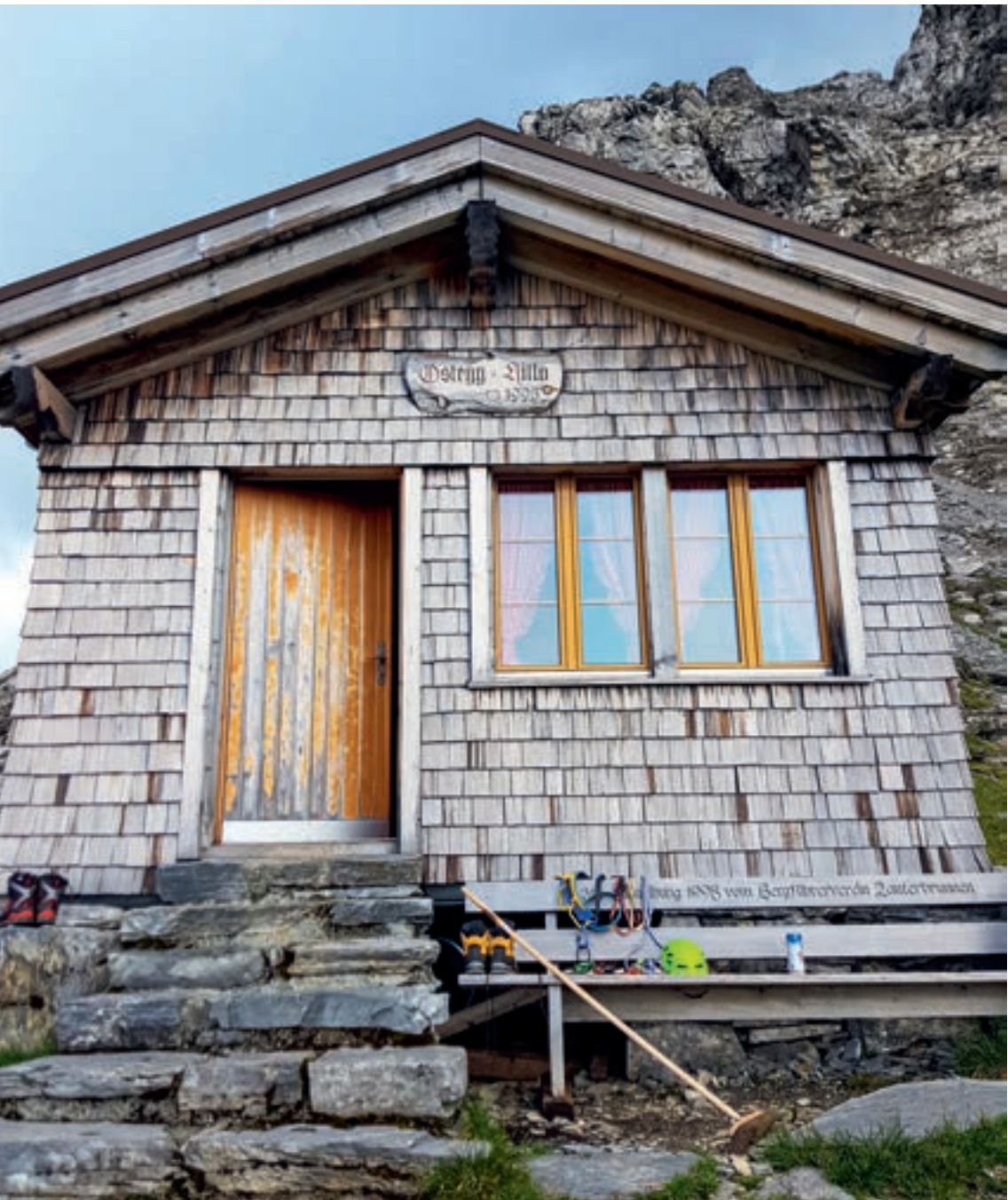
Die Ostegghütte wurde 1998 anlässlich des hundertjährigen Bestehens des Bergführervereins Grindelwald gebaut und thront seitdem auf 2320 Meter Höhe
