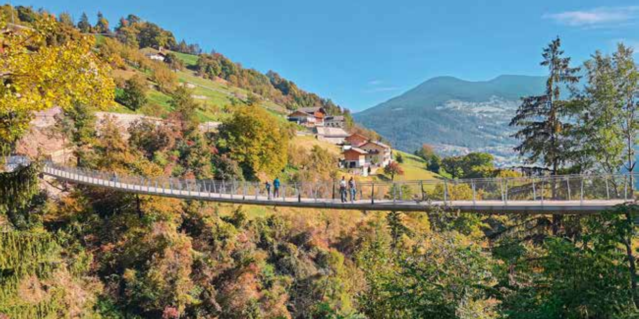
Panoramabrücke zwischen Barbian und Saubach
