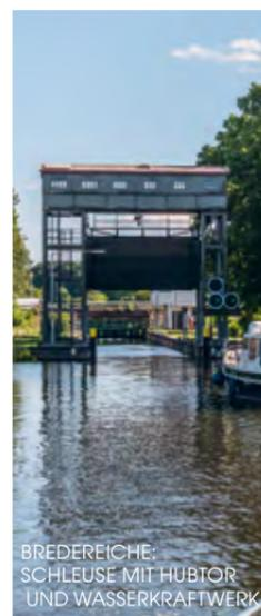
BREDEREICHE: SCHLEUSE MIT HUBTOR UND WASSERKRAFTWERK
