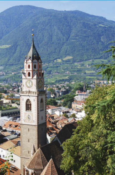
Der Turm der Pfarrkirche St. Nikolaus ragt stolze 80 Meter in die Höhe
