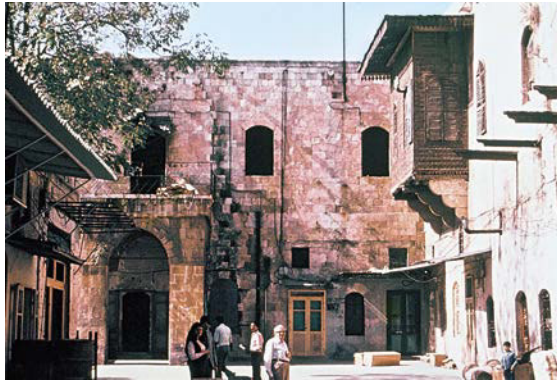
Ein Blick in den Hof der Karawanserei Fansa, erbaut im 18. Jh.
