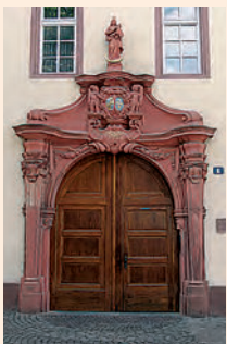
oben und rechts: Älterer Dalberger Hof, Ballplatz 1, 1598, Portal von 1710
