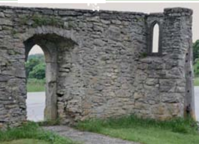
Reste der alten Klostermauer
