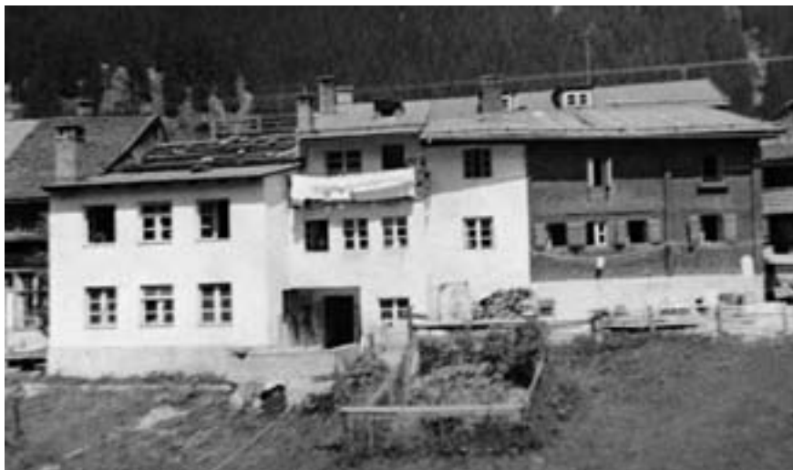
Mein Elternhaus in Nasserein. Das Kellergewölbe stammt aus der Zeit um 1480, die Stube aus dem Jahr 1680.
