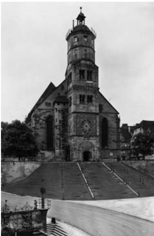
Die große, 60 Meter breite Treppe, die vom Marktplatz von Schwäbisch Hall zur römisch-gotischen Kirche leitet. Aufnahme aus dem Jahr 1937
