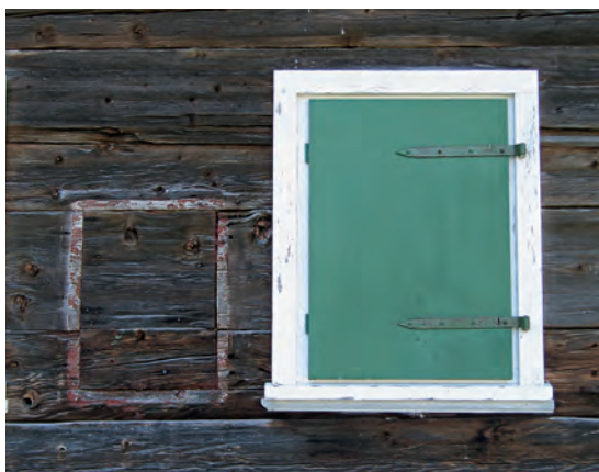
Oben: Wohnhaus, Laterns, Doppelfenster mit Butzenscheiben und dekorativem Zugladenkasten Unten: Wohnhaus, Böldmen, altes und neues Fenster. Man beachte die Größenunterschiede.
